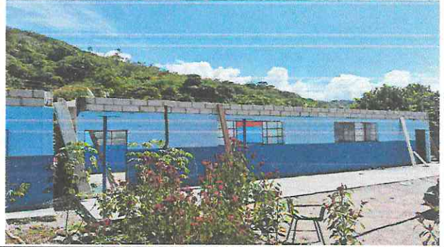
Foto 2: levantado de 2 hiladas de block para nivelacion de altura en aulas.
