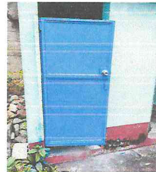
Foto 4: Colocación de puerta de baño.
