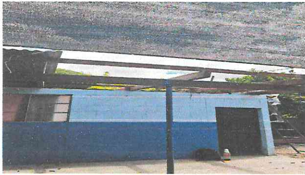
Foto1: Retiro de láminas en las aulas.
